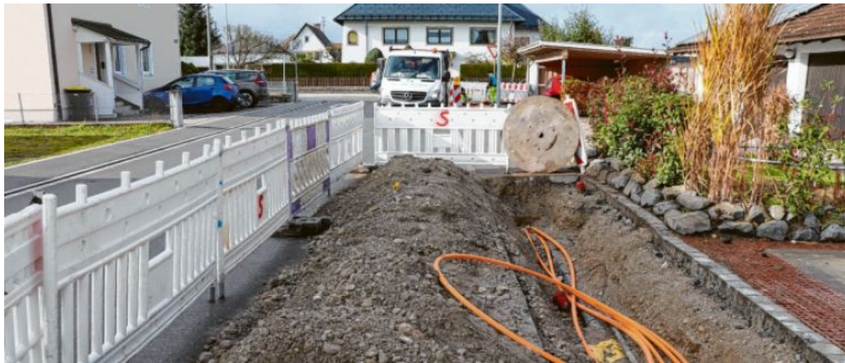
Kaum fertig ausgebaut, schon wieder aufgerissen: In der Badstraße werden Glasfaserkabel verlegt, um die Haushalte mit schnellem Internet zu versorgen. Die betroffenen Anlieger sind davon gar nicht begeistert. Foto: Alf Geiger
